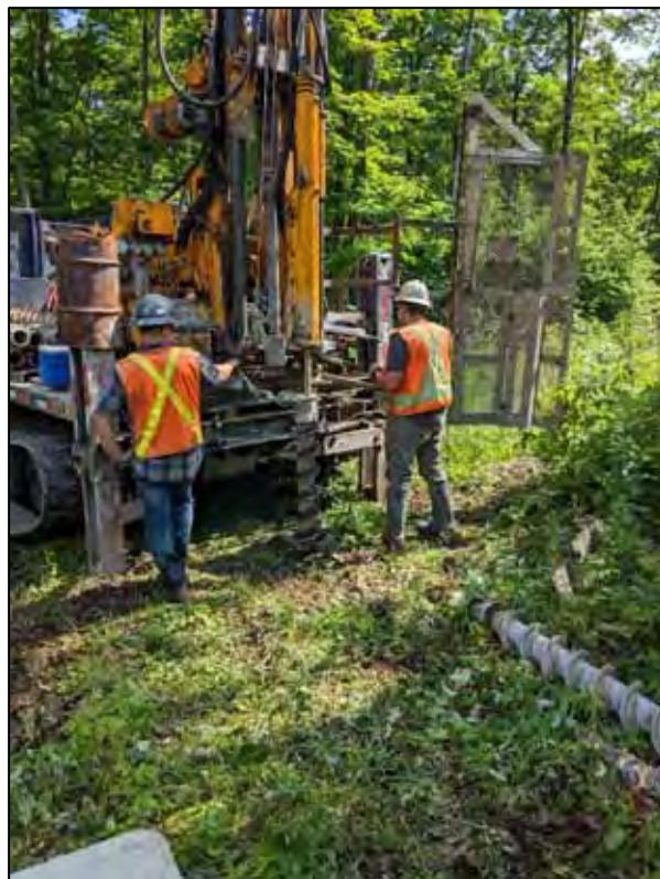
Photo 4 : Forage jusqu'au roc et installation de puits d'observation dans les dépôts de surface
