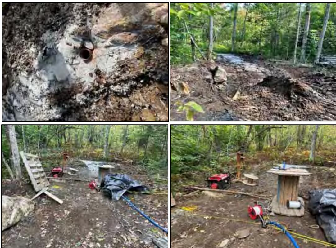
Photo 13 : Puits de pompage 23PP-3 : puits de diamètre PQ, zone d'aménagement du puits, système de pompage
